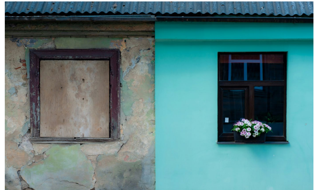
Kuva 15 Uusi ja vanha julkisivu
